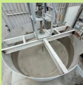
Fractionnement des boues de ponçage
